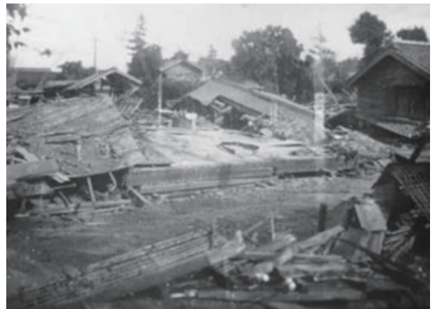
内閣府 三河地震報告書より 現安城市根崎町
